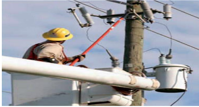
Рисунок 9.4 – Проверка отсутствия напряжения на токопроводящих частях перед их заземлением с помощью указателя напряжения с помощью изолирующей оперативной штанги
