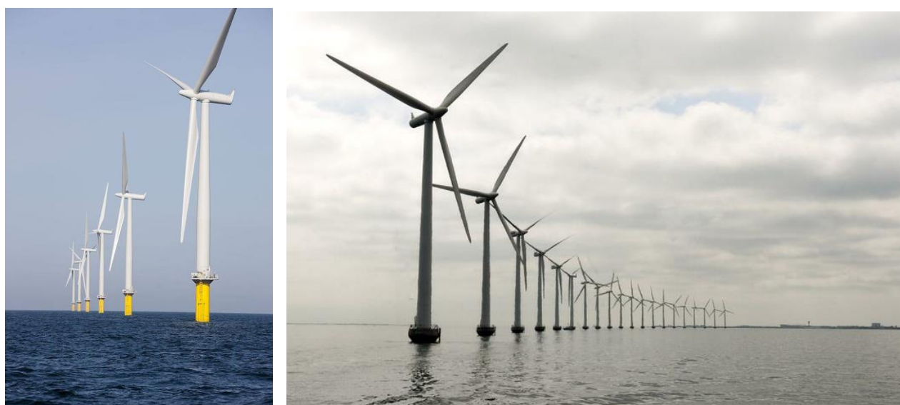
3.33 сурет – Даниядағы жел электр станциясы
