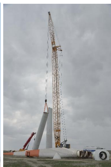
3.29 сурет – Үш қалақшалы жел генераторын орнату кезі
