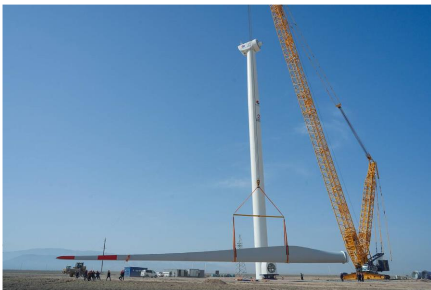
3.29 сурет – Үш қалақшалы жел генераторын орнату кезі
