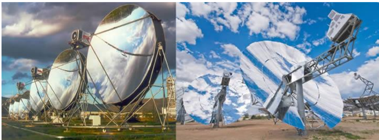
2.11 сурет – Параболалық концентраторларды қолданатын Стирлинг қозғалтқышымен жабдықталған күн электр станциялары
