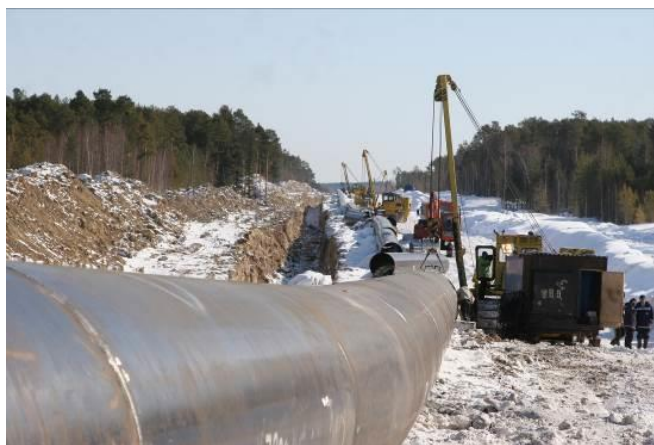
Рисунок 1.16- Сооружение подземного газопровода
